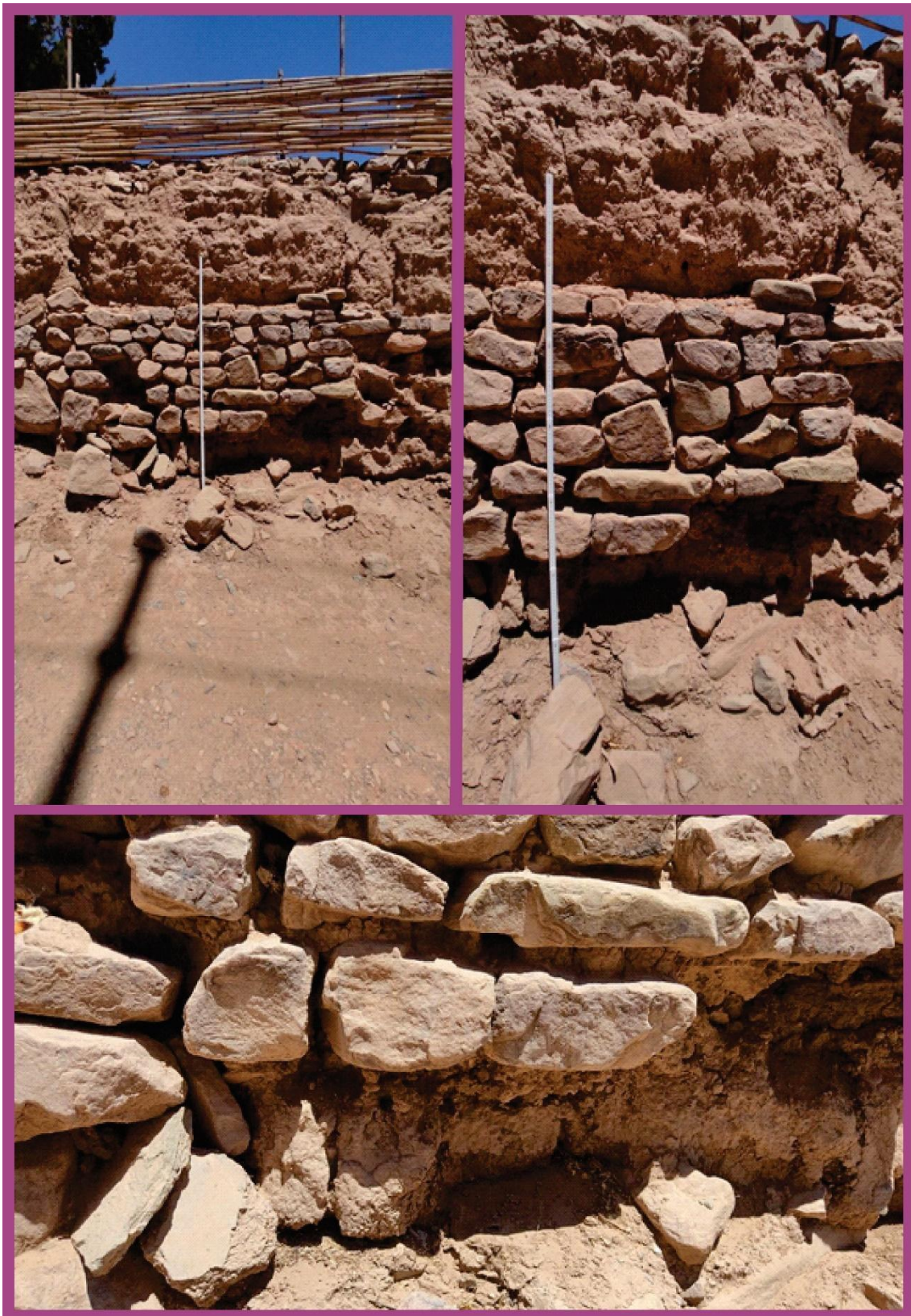
Figura 26. Muro arqueológico de Til.23 cubierto por alud de barro. Calle Sorpresa.
