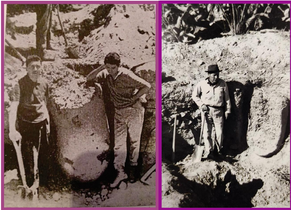
Figura 23. Hallazgo ocurrido en 1966 durante obras de construcción en el terreno de la Flia. Arroyo en Tilcara. A la izquierda se observa la parte de la pieza (olla tubular) completa. Imagen extraída de Etnia N°8. A la derecha se observa la misma pieza con un gran sector faltante. Fotografía recuperada de la exposición “La Botica de Tilcara. Vida y fotos de Félix Leonardo Pereyra” en el Museo Nacional Antonio Terry.
