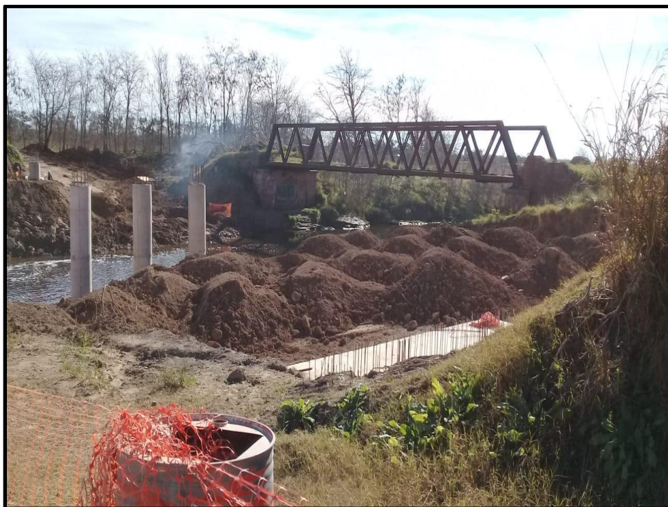
Figura 42: Estado de las obras para la construcción el nuevo puente que permite la comunicación entre las localidades de Goldney y Olivera a junio 2021 (foto del equipo de investigación).
