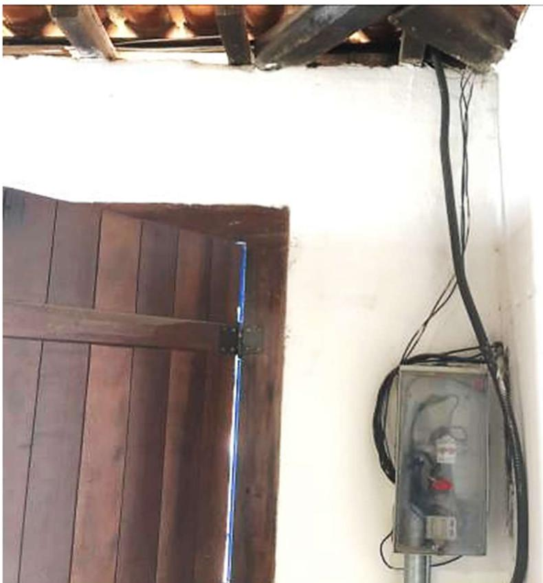
Figura 282: cuadro eléctrico instalado en la entrada de la Casa da Cultura, es visible la precariedad, la falta de profesionalidad en la realización del trabajo, así como la falta de un proyecto adecuado. Archivo fotográfico del autor.
