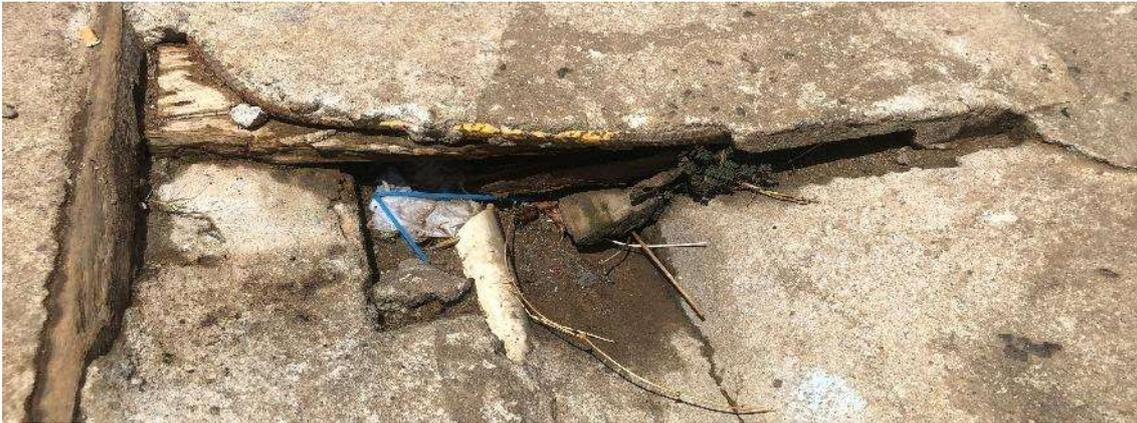
*Figura 225:* soluciones técnicas mal ejecutadas y no resueltas en la pavimentación alrededor del conjunto histórico. En la imagen, un punto potencialmente peligroso para la seguridad de peatones de tras de la Casa da Cultura. Archivo fotográfico del autor.
