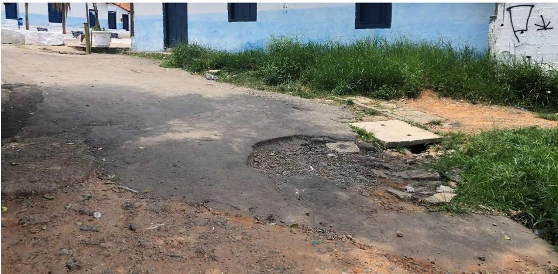
*Figura 148:* asfalto irregular, mal ejecutado y con cráteres perjudicando la accesibilidad y la seguridad de los peatones. Archivo fotográfico del autor.
