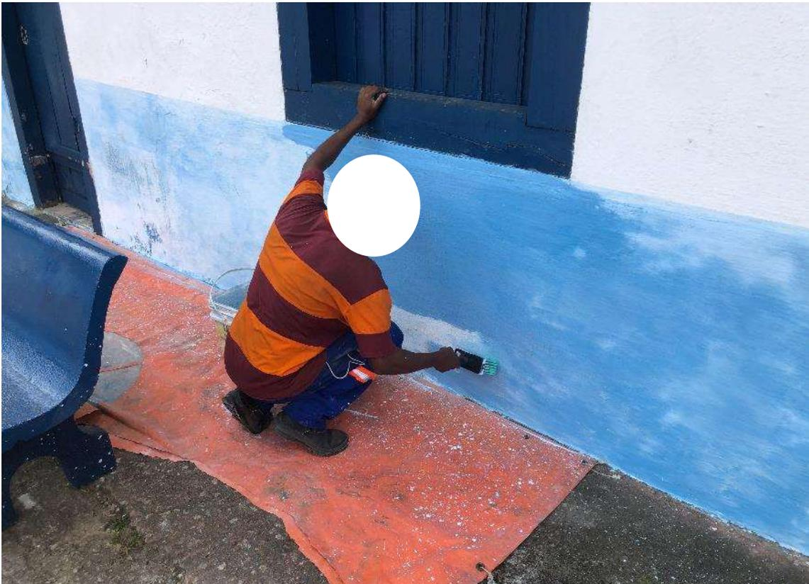
*Figura 237:* pintura a base de cal de las fachadas sin remoción de las capas pictóricas anteriores. Archivo fotográfico del autor.
