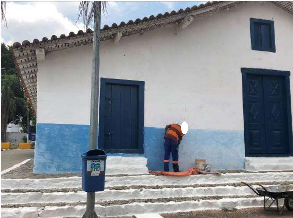
*Figura 238:* pintura a base de cal de las fachadas sin remoción de las capas pictóricas anteriores. Archivo fotográfico del autor.
