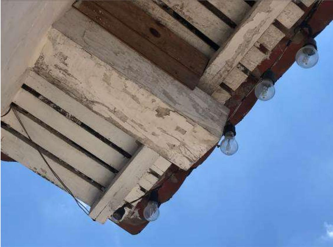
*Figura 280:* lámparas y cableado eléctrico expuestos en la borda de la cobertura de la capilla. Archivo fotográfico del autor.
