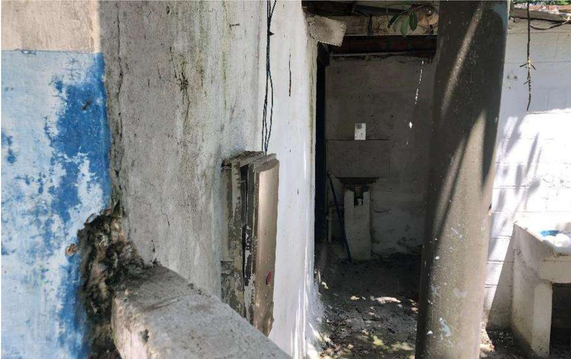
Figura 278: cuadro eléctrico en condiciones de potenciales peligros en la parte posterior de la casa 12. Archivo fotográfico del autor.
