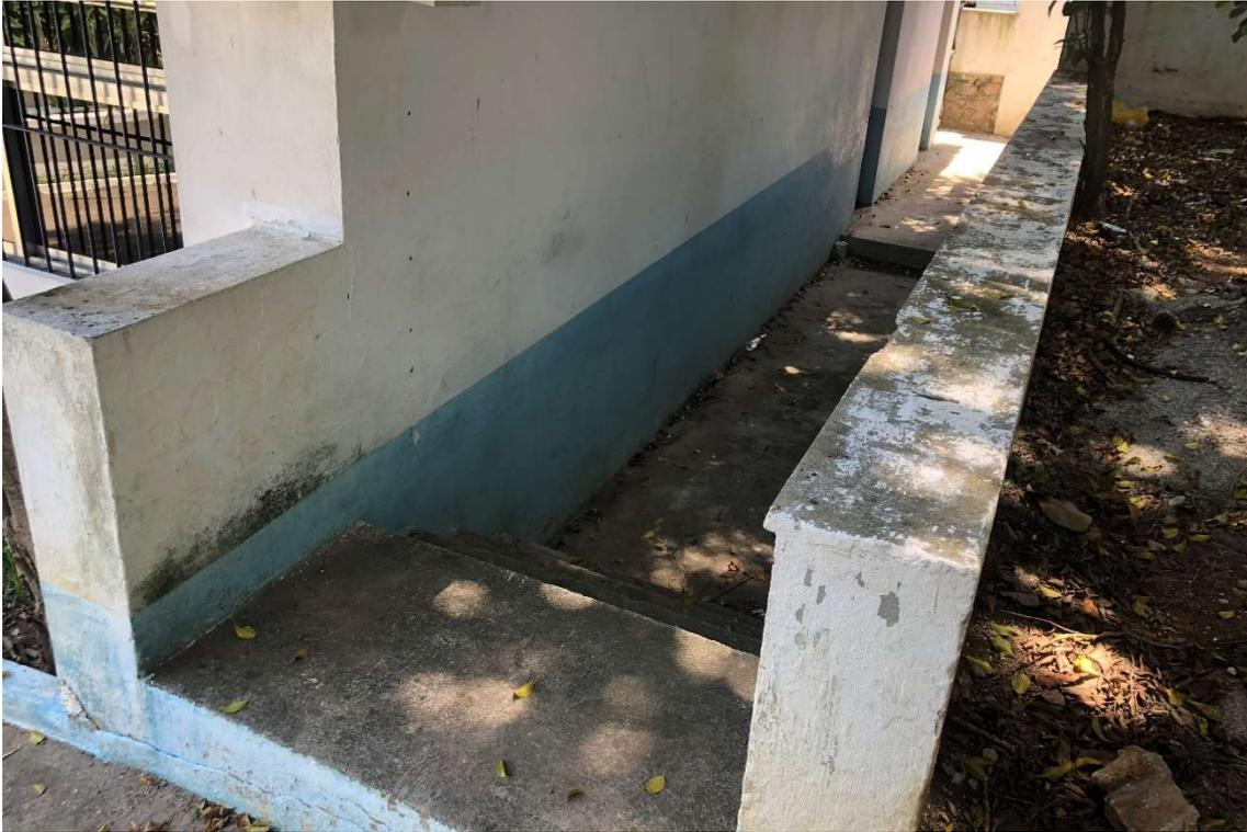
*Figura 170:* partes posteriores de las casas 18 y 19, con al fondo el acostamiento a la capilla. Se observan problemas en la accesibilidad, acumulo de basura y hojas, falta de limpieza y cuidados, mortero de revestimiento deteriorado. Archivo fotográfico del autor.
