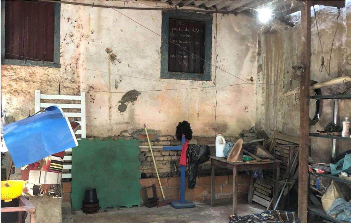
*Figura 180:* área de trabajo externa bajo estructura metálica simples. La pared con las dos ventanas, es la fachada posterior de la casa 5: se noten los ladrillos en la parte inferior, lo que implica una posible reconstrucción de la casa o de parte de ella. Archivo fotográfico del autor.
