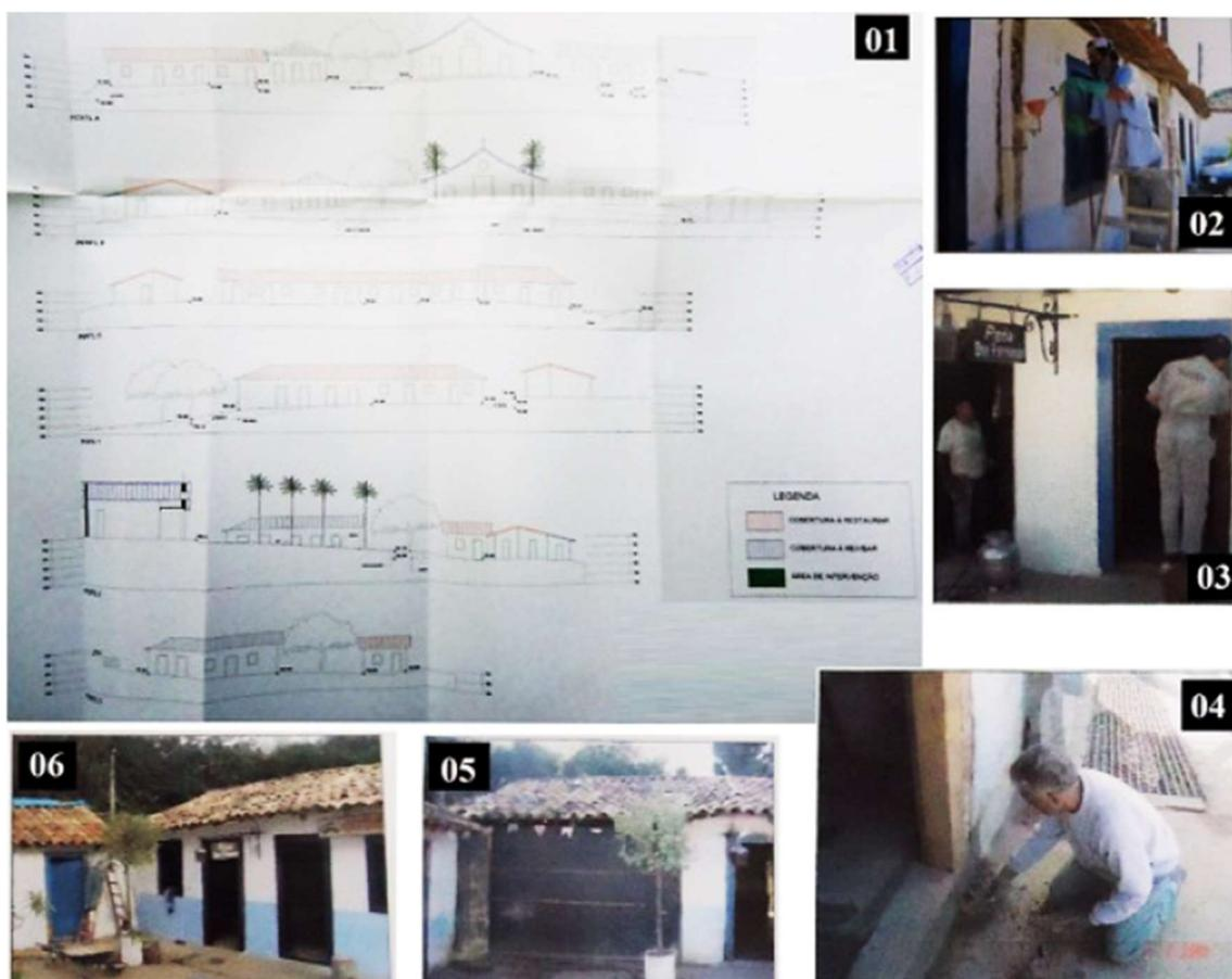
Figura 85: "1) Perfis para intervenção em el conjunto de la Aldeia de Carapicuíba; (2) Aplicación de productos contra termitas; (3) Pintura de puertas y ventanas; (4) Restauración de topes y umbrales; (5) Fachadas casas 01 y 02 como encontradas antes de la ejecución del proyecto; (6) Fachada después de la reconstrucción y restauración - 2004. Recursos Minc/SE/FNC. Fuente: Arquivo da 9ª SRIPHAN/SP" (OLIVEIRA, 2016, p. 281).
