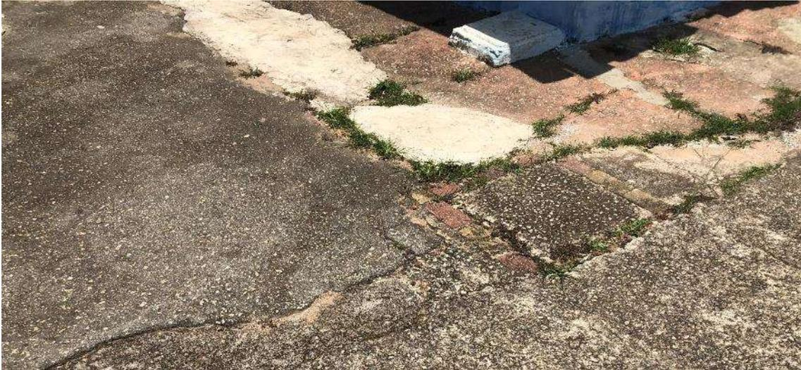
*Figura 222:* trabajos mal ejecutados para el enterramiento del cableado eléctrico público. Archivo fotográfico del autor.
