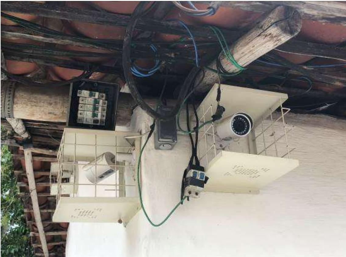
Figura 279: cableado eléctrico y cajita con disyuntores completamente expuestos (casa 1). Archivo fotográfico del autor.
