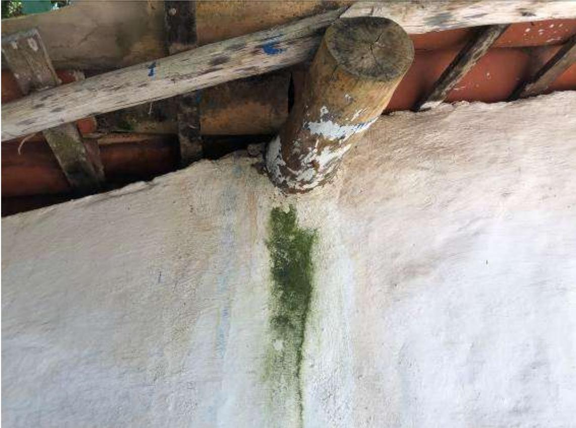
*Figura 252: moho probablemente causado por la putrefacción de parte del palo de madera que sustenta la jácena. Archivo fotográfico del autor.*
