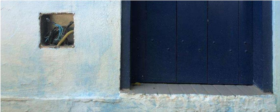
*Figura 248:* caja eléctrica abierta y desprotegida en la lateral de la casa 19. Archivo fotográfico del autor.
