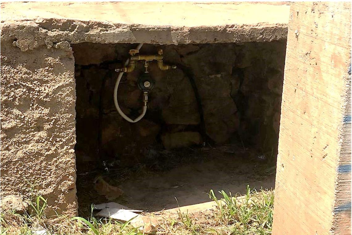
Figura 286: vano abierto y desprotegido con instalación de un punto para fornecimiento de gas. Archivo fotográfico del autor.
