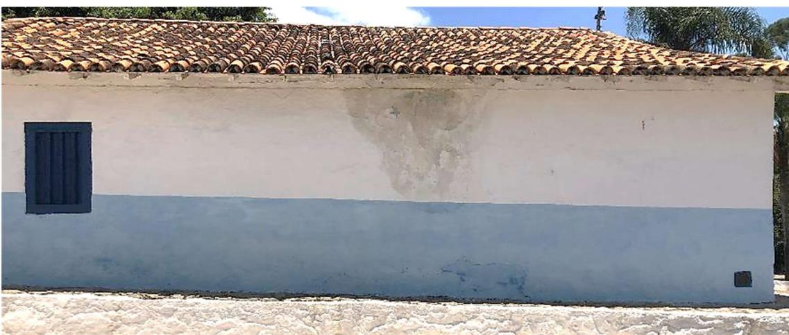
*Figura 239:* la pared lateral derecha de la capilla con la evidente mancha de agua. Archivo fotográfico del autor.
