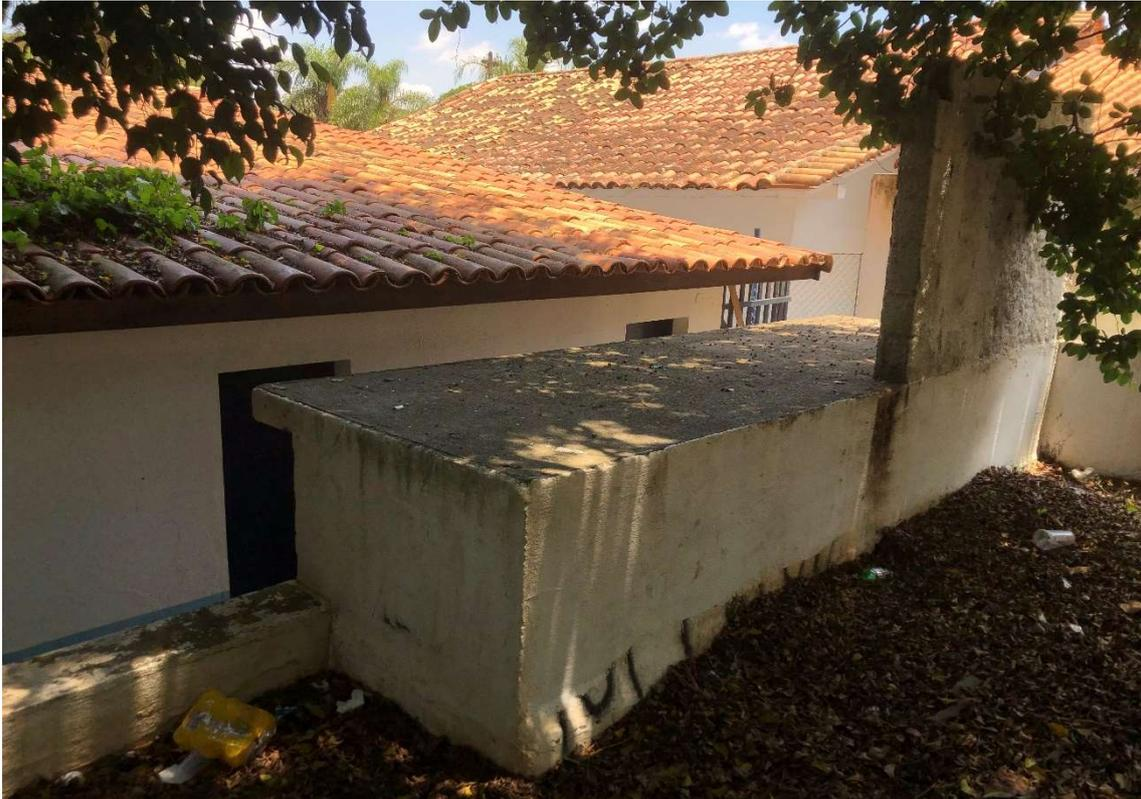
*Figura 168:* conjunción entre la casa 18 y la capilla; acumulación de basura y hojas por cima de elementos arquitectónicos añadidos en épocas modernas o de construcciones anteriores demolidas, en estado de degradación superficial. Archivo fotográfico del autor.
