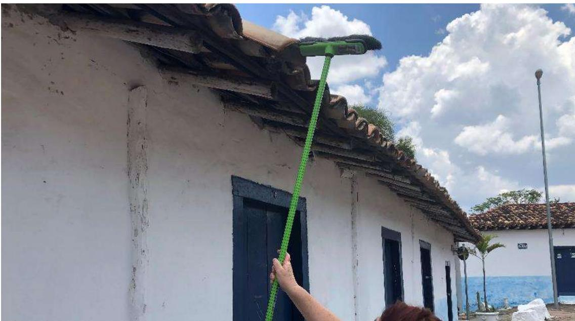
*Figura 266:* las tejas no poseen estabilidad, al punto de representar un real peligro para peatones. En la imagen, la propietaria de la casa 5 intentando evitar la caída de una teja. Archivo fotográfico del autor.
