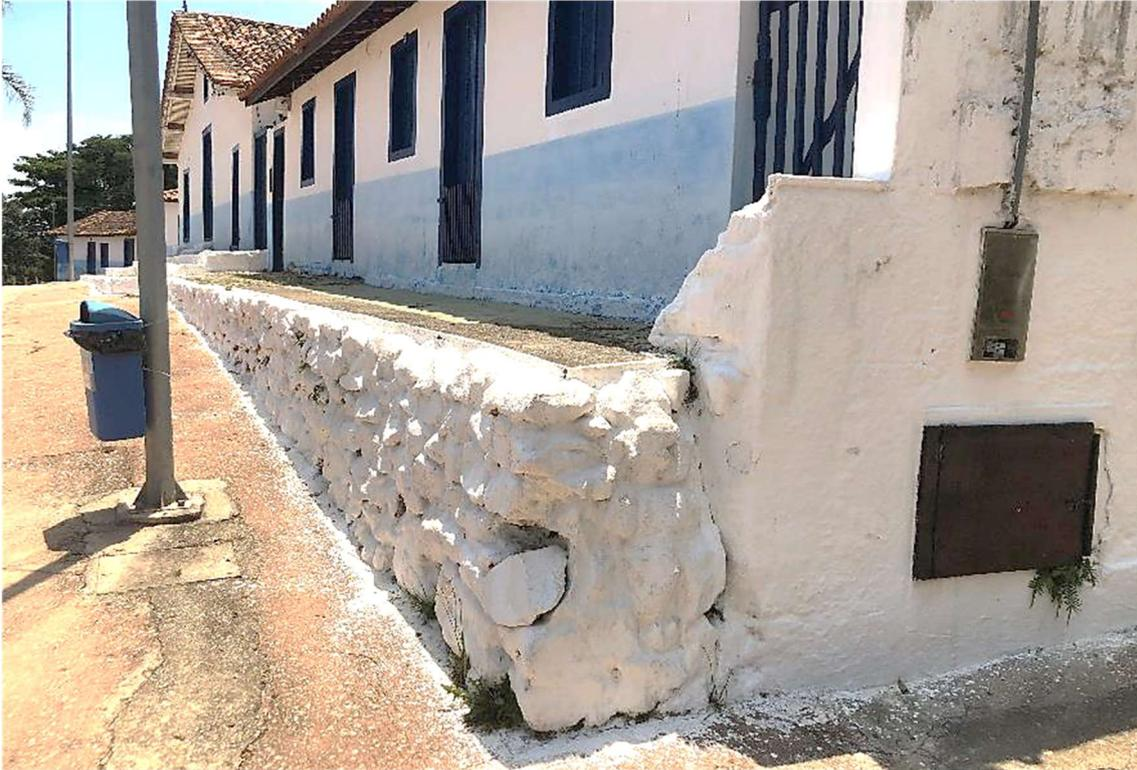
*Figura 231:* acera en frente a los accesos de las casas 18 y 19, sin protección y con diferencias de altura importantes imposibilitando la accesibilidad y perjudicando la seguridad. Archivo fotográfico del autor.
