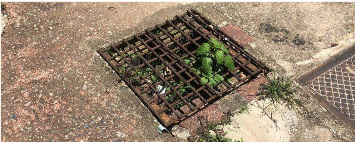
*Figura 224:* pozos para el drenaje del agua pluvial protegidos por rejilla improvisada y realizada con hierros para armaduras. Archivo fotográfico del autor.
