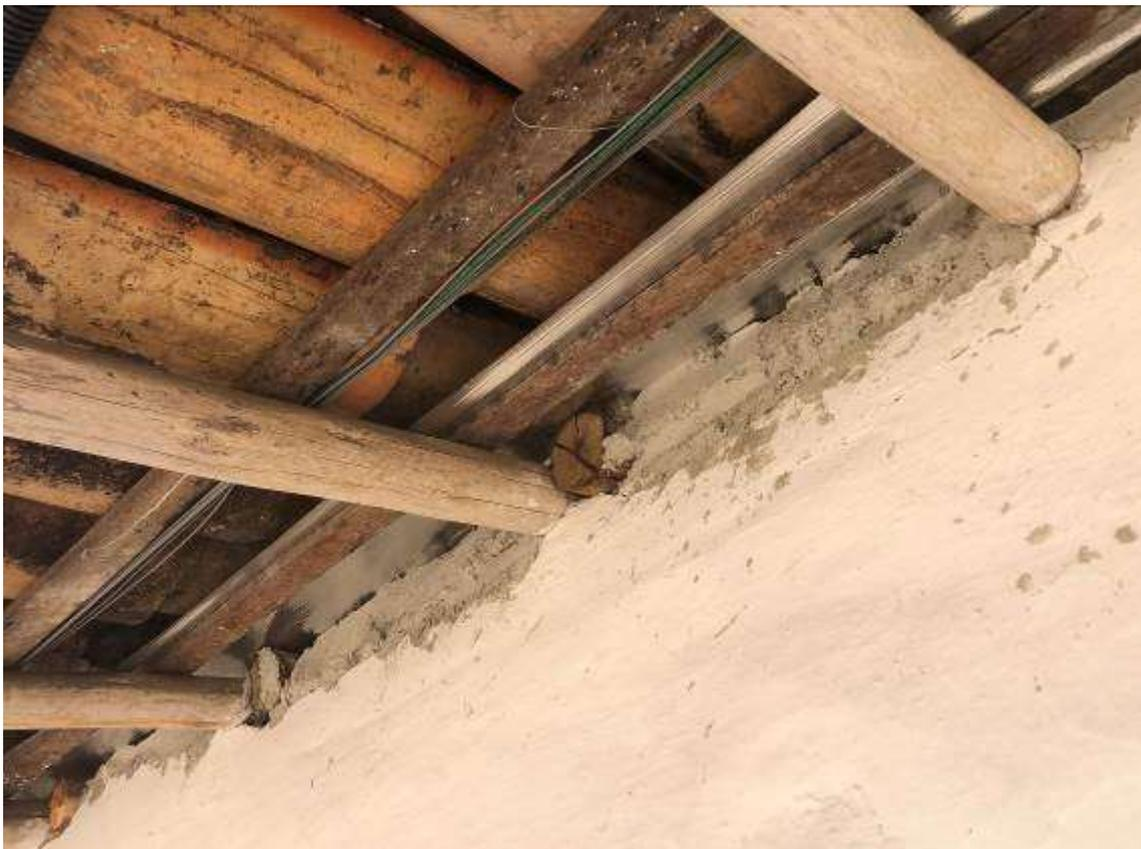
*Figura 270:* es común a todo el conjunto que el encuentro entre pared y cobertura sea mal ejecutado, perjudicando la seguridad y la vida útil de los materiales. Archivo fotográfico del autor.
