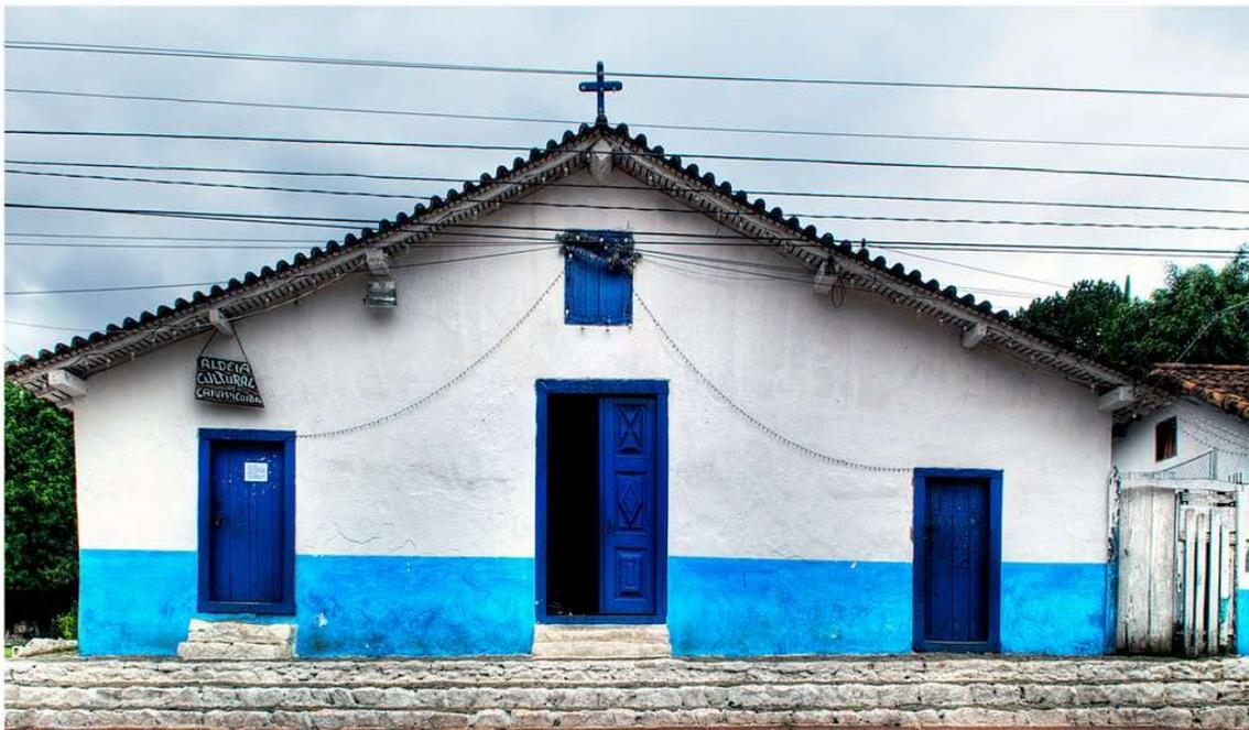
Figura 31: fachada de la capilla de *São João Batista*, con accesos independientes, inexistencia cuasi que total de ornamentación, concentrada en la puerta acolchada y en el barrado azul. Se note también la pequeña puerta rectangular de la campana, conforme esquema de la figura 64. Foto: Wilson Houck Jr. Extraída de: <http://eboaviagem.blogspot.com/2016/03/2603-aniversario-de-carapicuiiba.html>
