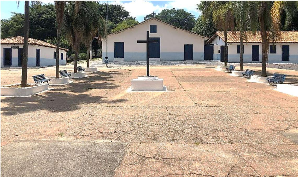
*Figura 218:* placas en hormigón no armado en el patio del sitio histórico. Es visible que en correspondencia del adro central, las placas presentan menor ruptura, pues es el área que nunca fue interesada por el tránsito de vehículos. Archivo fotográfico del autor.
