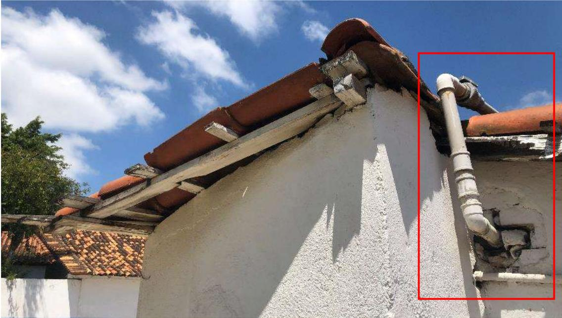
Figura 287: instalación precaria y antiprofesional de tuberías hidráulicas sin cuidados para la integridad física de los cuerpos edilicios. Archivo fotográfico del autor.
