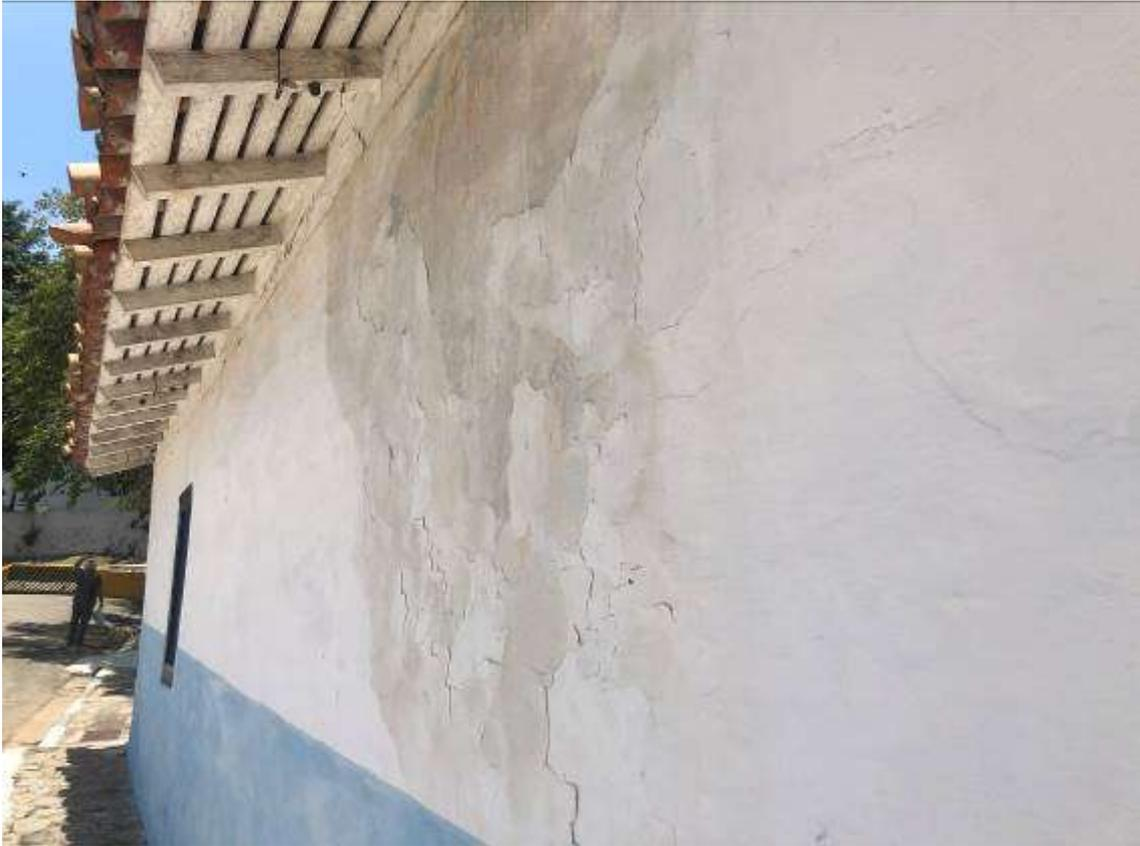
*Figura 240:* la mancha de agua en la pared lateral derecha de la capilla causando el desprendimiento de la capa pictórica. Archivo fotográfico del autor.
