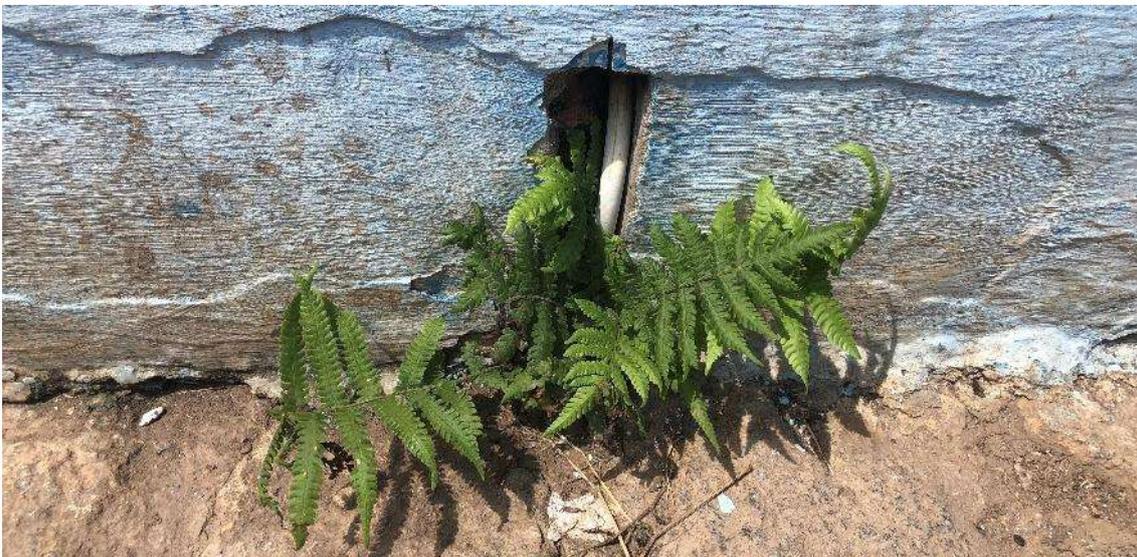
*Figura 247:* material parietal faltante donde pasan instalaciones hidráulicas, provocando acumulo de humedad e invasión biológica. Archivo fotográfico del autor.
