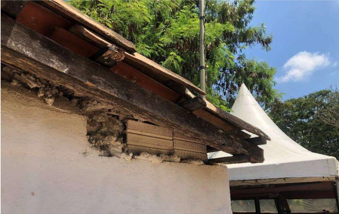
*Figura 269:* trabajos improvisados y mal ejecutados en la realización de la cobertura. La imagen muestra una situación entre la Casa da Cultura y el Rancho da Viola. Archivo fotográfico del autor.
