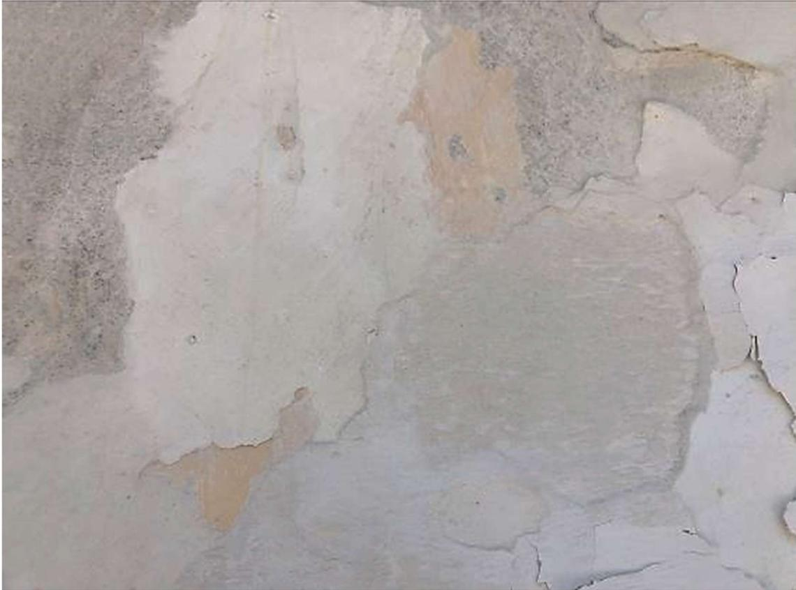
*Figura 242:* los colores de las capas pictóricas anteriores, ciertamente alterados por agentes atmosféricos y humedad generando eflorescencias. Archivo fotográfico del autor.
