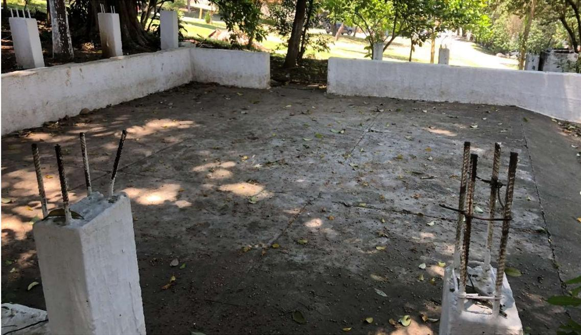
Figura 145: espacio para socialización cerrado por muretes y hierros se extendiendo para fuera de las pilstras, extremadamente peligroso principalmente para niños. Se note también la degradación de la pavimentación en hormigón armado. Archivo fotográfico del autor.
