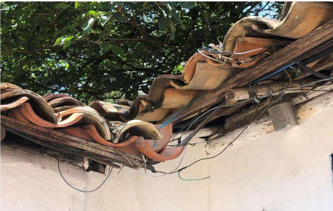
*Figura 281:* es común a todo el conjunto encontrar cableado eléctrico instalado de forma precaria e improvisada. La imagen muestra la situación entre las casas 1 y 2. Archivo fotográfico del autor.
