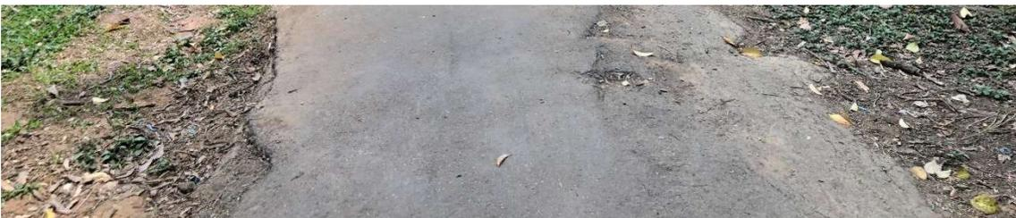
Figura 152: asfalto irregular y mal ejecutado al lado de los juegos. Archivo fotográfico del autor.
