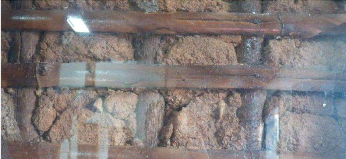
Figura 28: tramo de pared en *pau-a-pique* visible en una das casas y protegida por vidrio. Foto de Valter Barcala. Fuente: <http://valterbarcala.blogspot.com/2012/10/carapicuiba-em-imagens.html>
