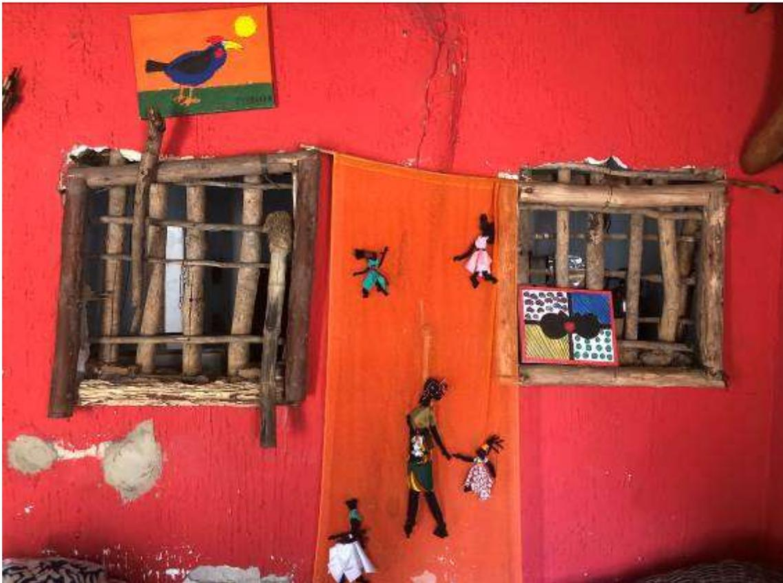
Figura 260: las dos ventanas abiertas por la propietaria de la casa 5 entre la sala de estar y la cocina, dejando la estructura en *pau-a-pique* libre de todo el barro. Archivo fotográfico del autor.
