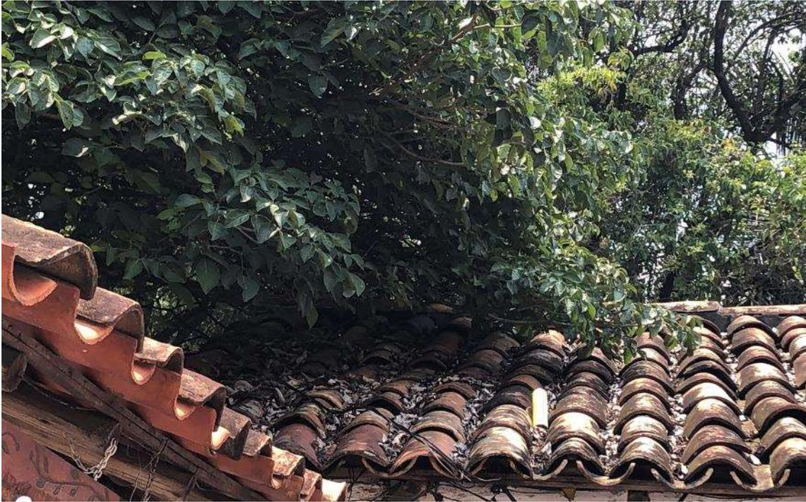
*Figura 267:* falta de manutención en los árboles perjudicando la seguridad y la vida útil de las coberturas. La imagen muestra la situación entre las casas 1 y 2. Archivo fotográfico del autor.
