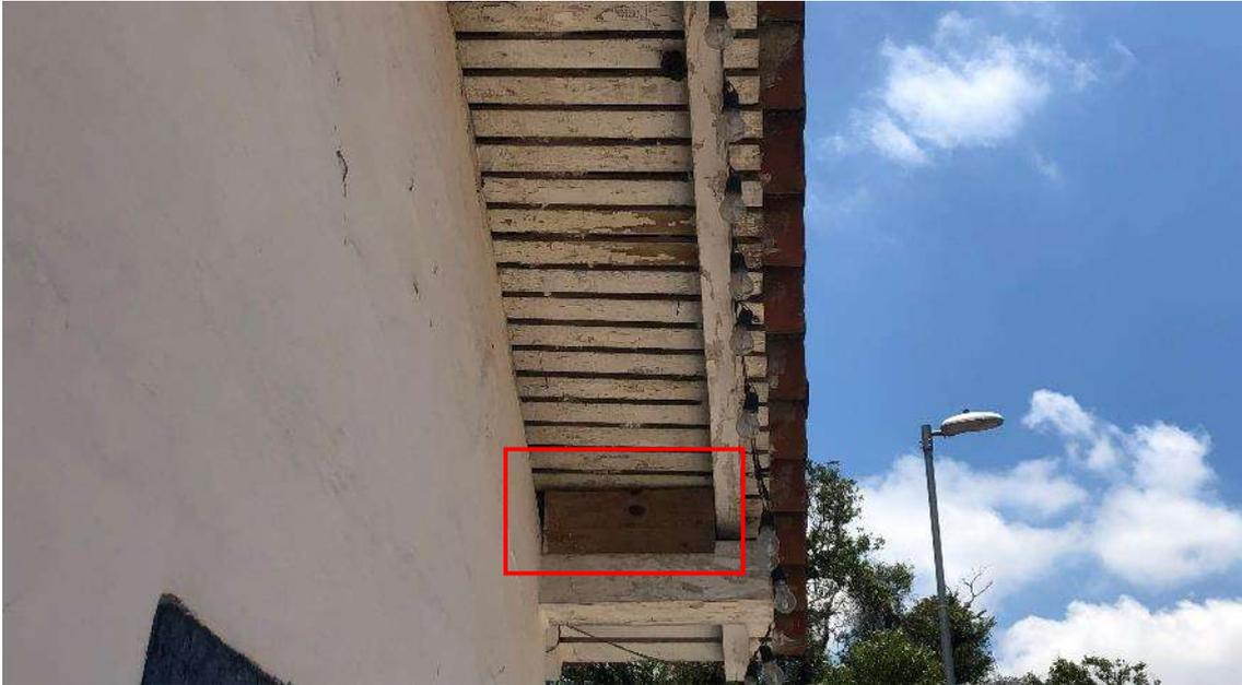
*Figura 265:* parte externa de la estructura de la cobertura de la capilla. Se percibe un estado de degradación material avanzada, y soluciones improvisadas para la protección contra volátiles, como en el punto enmarcado por el rectángulo rojo. Archivo fotográfico del autor.
