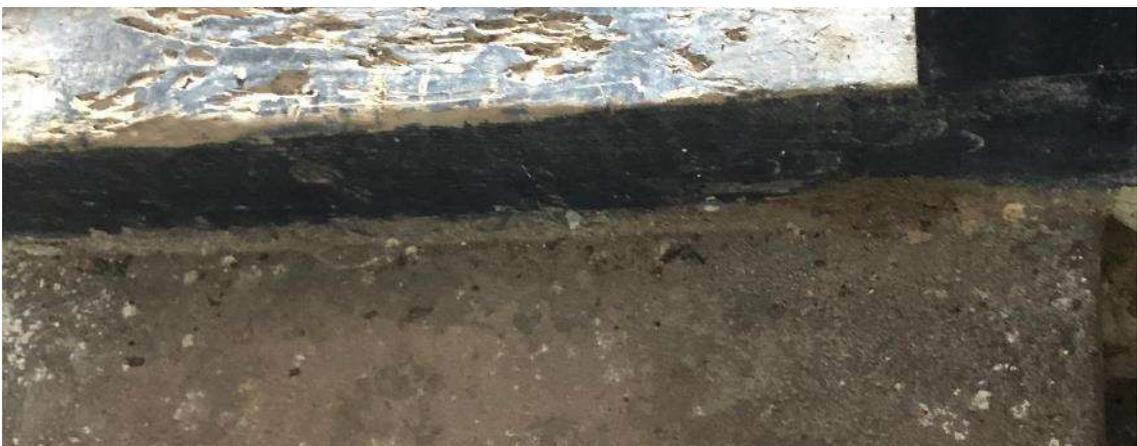
Figura 261: detalle evidenciando el desgaste material de la madera de una puerta interna e de un peldaño en la casa 12. Archivo fotográfico del autor.
