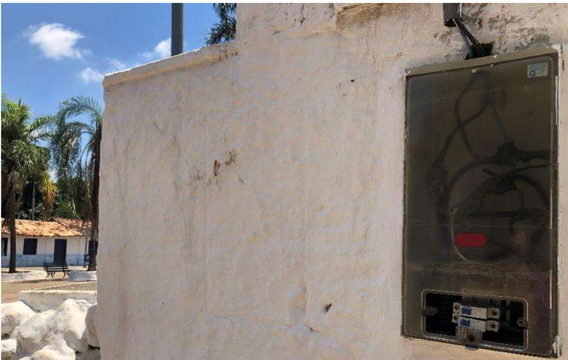
Figura 277: cuadro eléctrico en función también al lado de la casa 19. Se noten los disyuntores completamente expuestos. Archivo fotográfico del autor.
