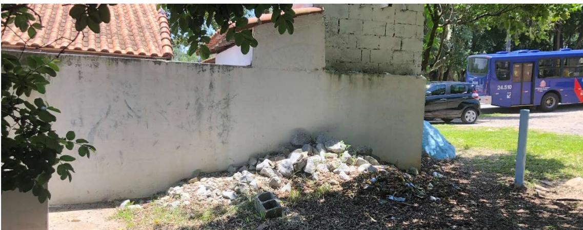
*Figura 167:* acumulación de hojas y basura de material de construcción apoyada al recinto de la capilla. Archivo fotográfico del autor.
