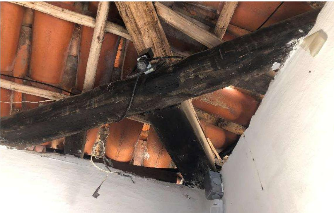
*Figura 272:* canto interno que evidencia la falta de tapamiento entre paredes y cobertura (*Casa da Cultura*). Archivo fotográfico del autor.
