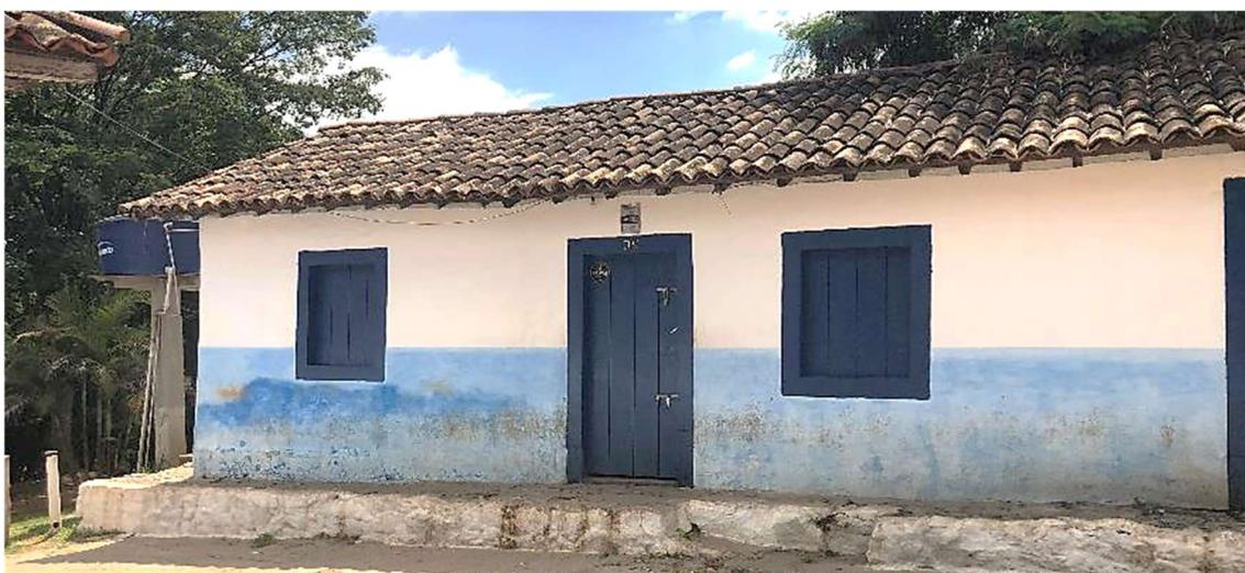
Figura 244: humedad ascendente o causada por la ruptura de instalaciones internas en las casas 13, 14 y 15 (*Rancho da Viola*), provocando inclusive el desprendimiento de la capa pictórica. Archivo fotográfico del autor.
