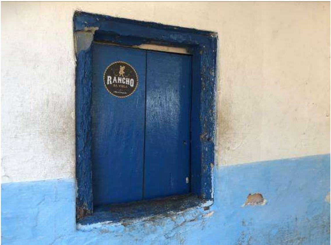
Figura 258: desgaste en la estructura de una ventana en la parte posterior de la casa 14 (Rancho da Viola). Archivo fotográfico del autor.
