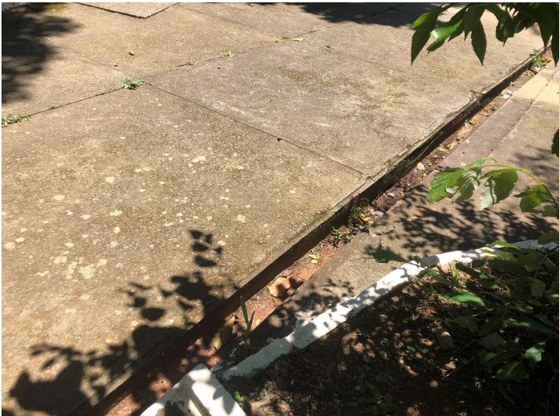
*Figura 144:* canal a cielo abierto para el drenaje del agua, acumulando suciedad perjudicando la movilidad y la accesibilidad. Archivo fotográfico del autor.
