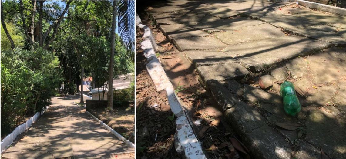
*Figura 143:* pavimentación en placas de hormigón no armado se destruyendo, en condiciones inaceptables para responder a los requisitos mínimos de accesibilidad. Archivo fotográfico del autor.
