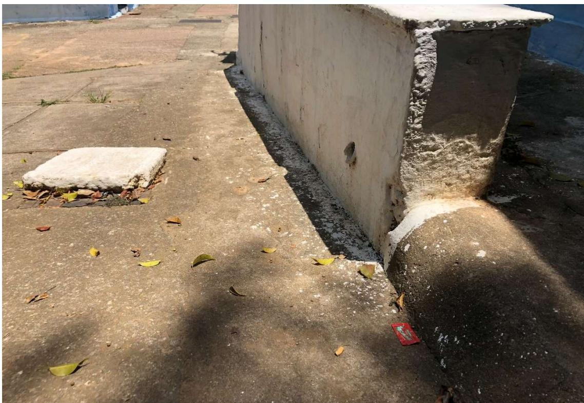
*Figura 188:* pozos mal tapados y problemas de accesibilidad en la entrada al patio del sitio histórico al lado de la casa 19. Se note también la tabulación para salida del agua pluvial directamente en el camino. Archivo fotográfico del autor.
