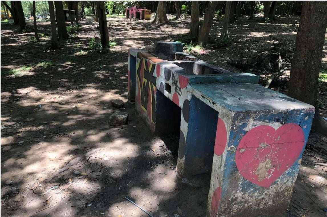
*Figura 121:* tabla en hormigón para barbacoa, vandalizada y sin mantención. Suciedad y descuido del terreno son visibles. Archivo fotográfico del autor.
