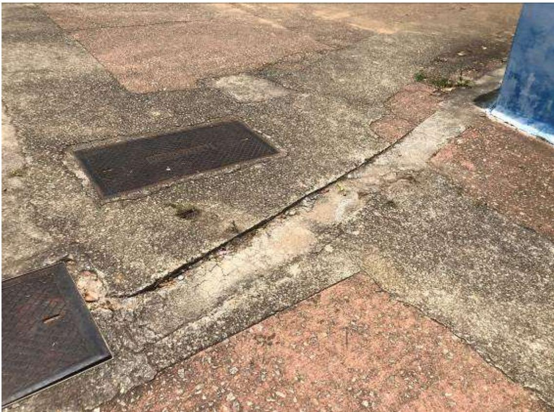
*Figura 221:* trabajos mal ejecutados para el enterramiento del cableado eléctrico público. Archivo fotográfico del autor.
