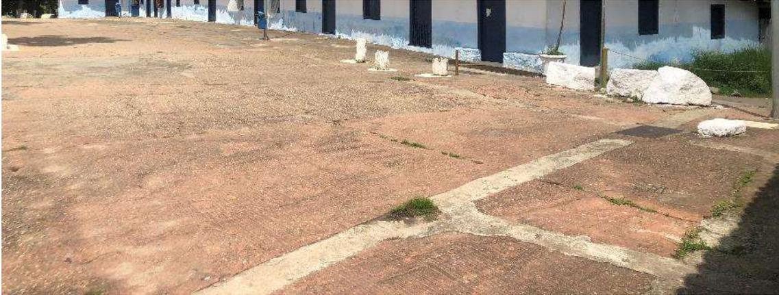
*Figura 220:* son visibles los caminos abiertos para el enterramiento del cableado eléctrico público y después cerrados con material diferentes al de la pavimentación del patio. Archivo fotográfico del autor.
