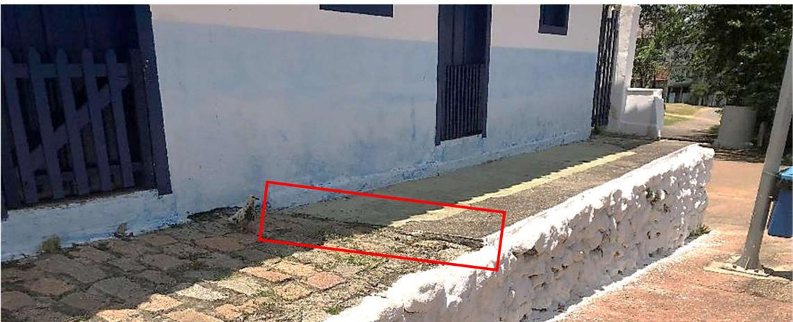
Figura 234: los altos peldaños de acceso a las casas 18 y 19. Se note los diferentes tipos de piso en la acera dificultado incluso a la movilidad, especialmente en punto enmarcado en el rectángulo rojo. Archivo fotográfico del autor.
