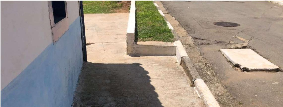
*Figura 186:* a la derecha es posible ver un pozo mal tapado. Se note incluso como los bordillos también ayudan en la creación de barreras arquitectónicas y se note la mala ejecución del asfalto en proximidad de los mismos. Archivo fotográfico del autor.
