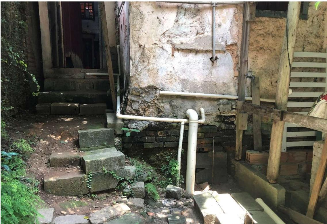
*Figura 181:* detalle de la fachada posterior de la casa 5. Se noten la precariedad de las soluciones técnicas - cuales tuberías para flujo de agua, residuos líquidos y tuberías para cables eléctricos -, y la extrema degradación de la construcción. Archivo fotográfico del autor.
