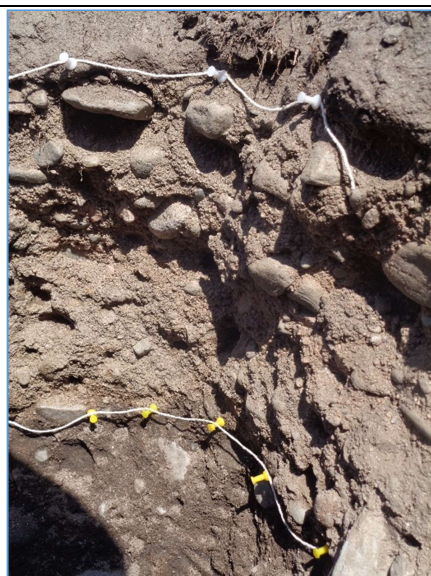
Sedimentos que responden al relleno del predio, donde se observa ripio que no responde al desarrollo natural del suelo del predio.
