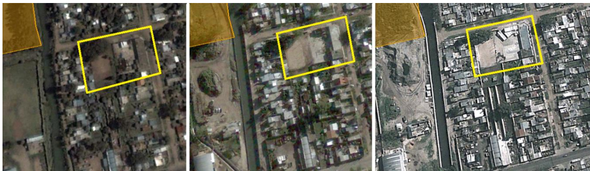
21. Club Manantial. Avances de obra 2000-2010-2012. Elaboración propia.
