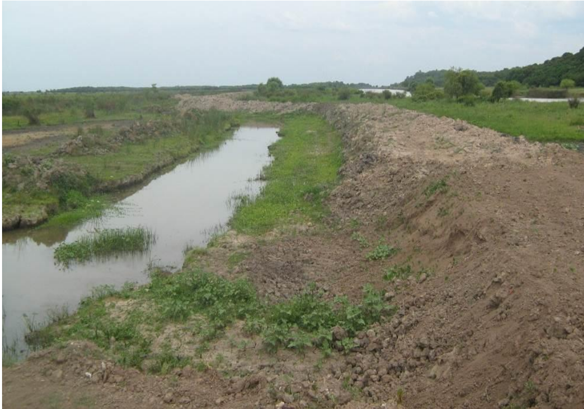
Construcción de terraplén. Ribera del río Baradero. Fotografía: Julia Gastellu.
