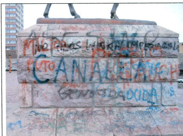
Palimpsesto en el monumento a Roca. Foto: María Teresa Causa
