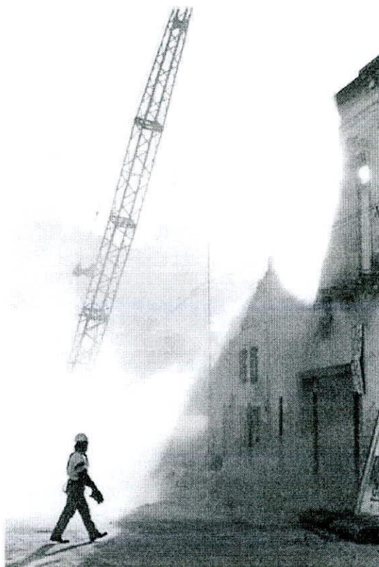
Demolición de una casa sobre la calle Guardia Vieja para la construcción del hipermercado COTO.
