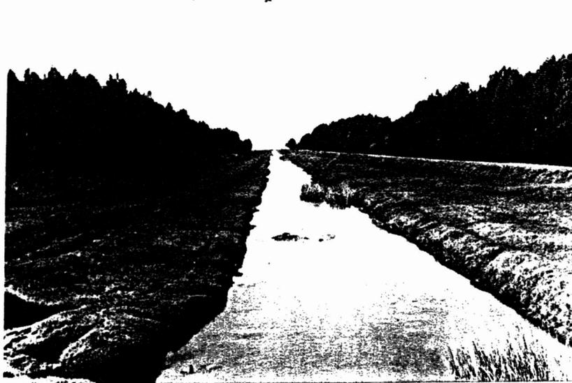
Foto N° **24** Canal N°5, en la ruta nac. n°2. Hacia el este. Este canal no desbordó durante la inundación de invierno de 1978. Se aprecia su lecho menor y mayor y la forestación en ambas márgenes.
