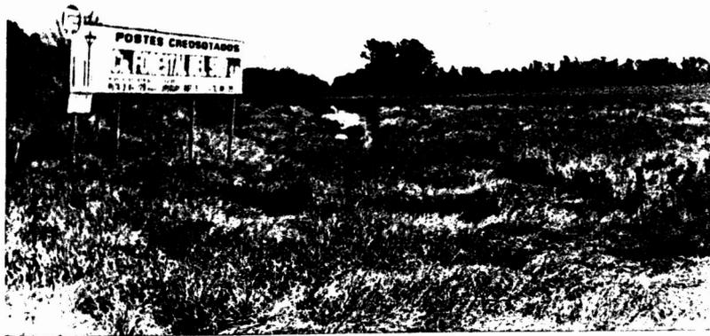
Foto N° **25** Ruta 3 Km. 100. Partido de Monte. Se aprecia un canal menor, obturado por la vegetación, es causal del encharcamiento de los campos aledaños.
