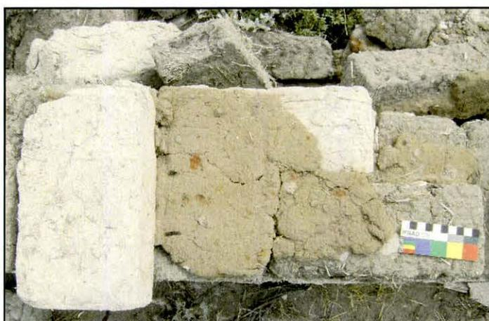
Figura 7.2.4. Disposición de ladrillos de champa.
