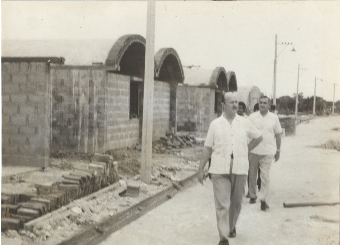
Imagen 42. Fotografía de la visita realizada por el gobernador Deonildo F. Bittel en 1975 a la construcción de viviendas del Barrio Toba. (Colección Archivo Histórico de la Provincia del Chaco).
