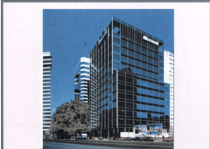
Torre Bouchard 710 (n° 165)
