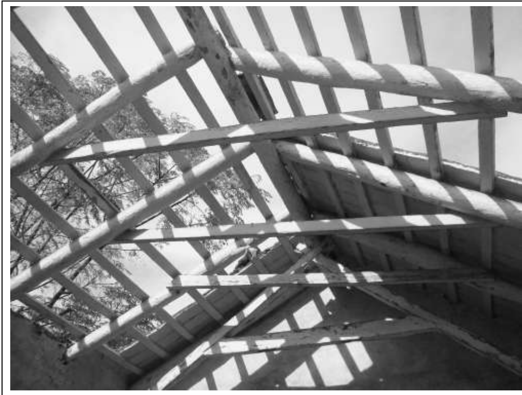
Figura 7. Vista del techo en proceso de desarme, desde el interior de la habitación A
