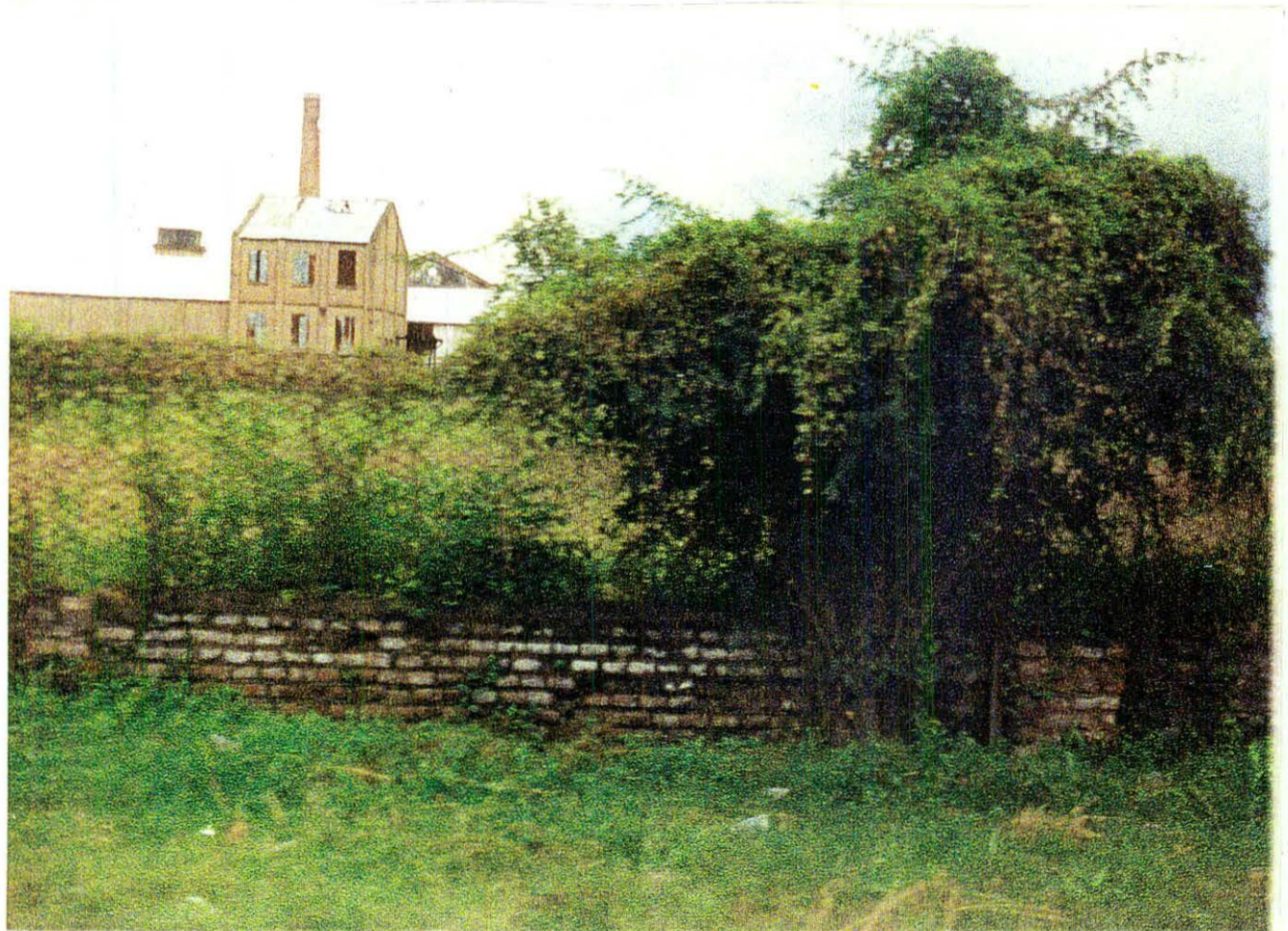
Instalaciones del antiguo Ingenio Luján.
