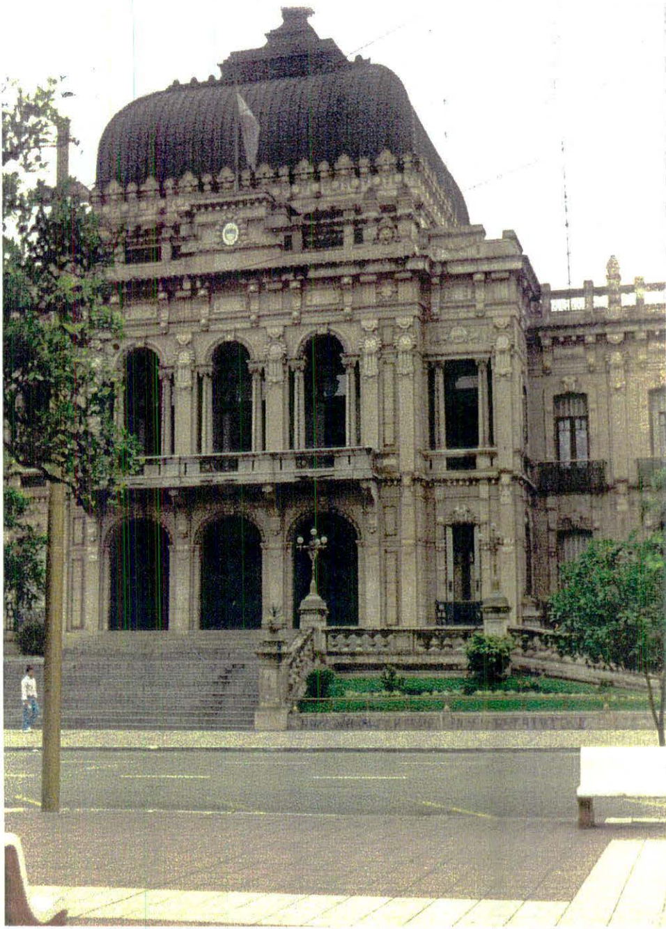
Edificio del Poder Ejecutivo Provincial, construido en el siglo pasado, muestra de una grandeza, hoy perdida.
