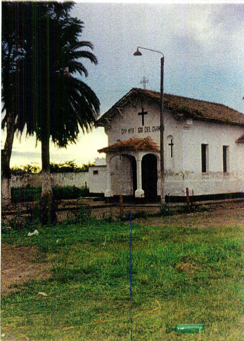
Capilla de Nuestra Señora del Carmen, ubicada dentro de lo que fuera el ingenio, hoy solo abre sus puertas una vez a la semana por falta de sacerdotes y feligreses.
