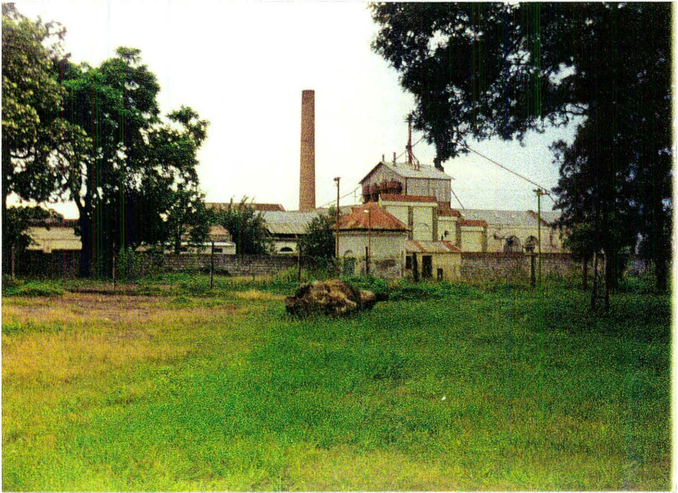
Estado actual de las instalaciones edilicias del Ingenio Esperanza.
