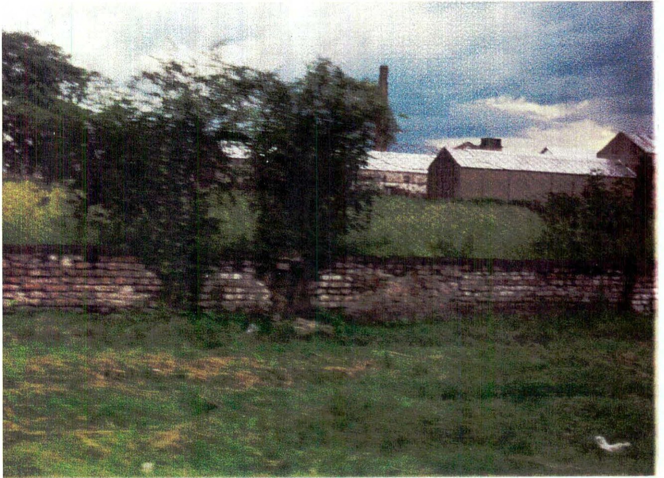
Edificio del Ingenio Luján .
