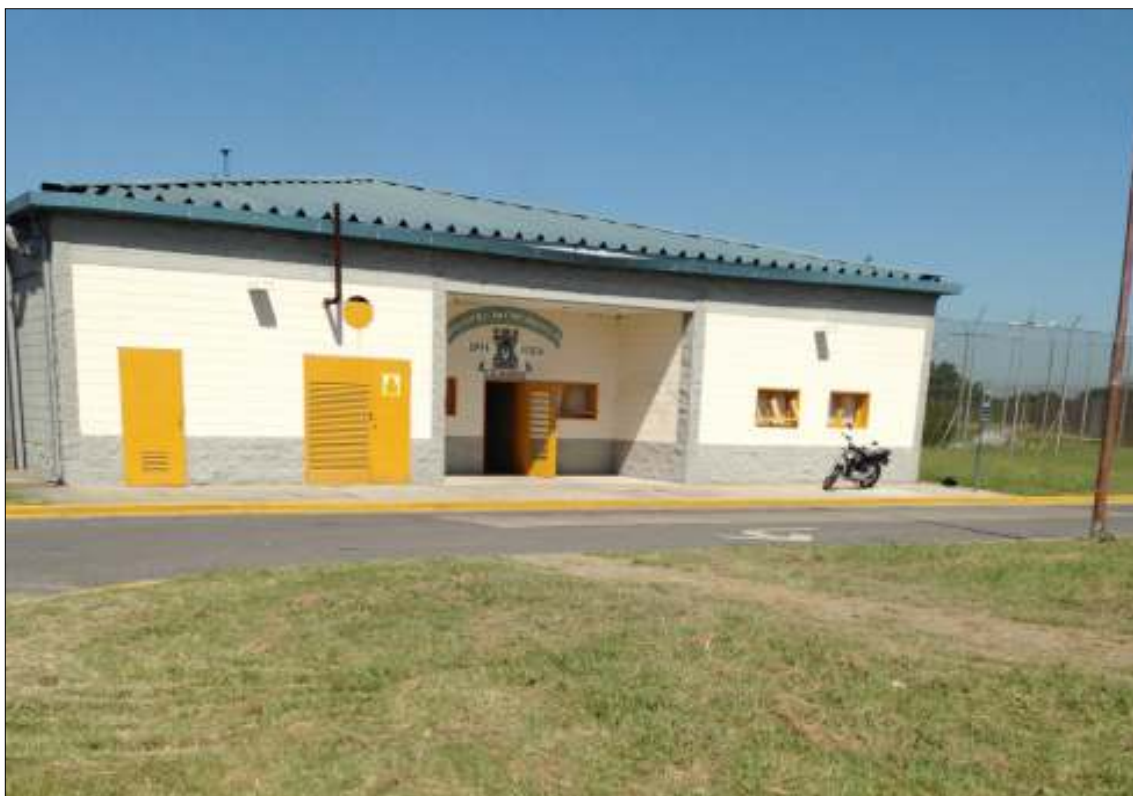
Fuente: Archivo personal de la autora, 2013. Fachada Módulo de Ingreso, CPF I.
