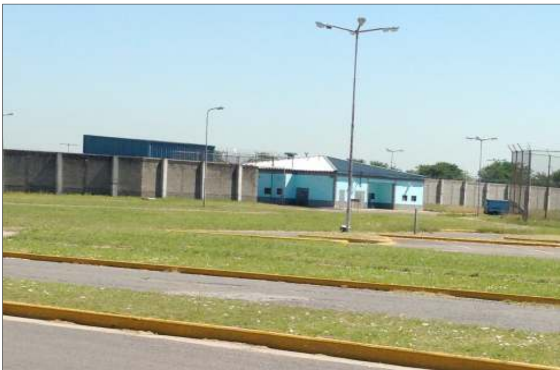
Fuente: Archivo personal de la autora, 2013. Vista exterior, Anexo Unidad N°20, CPFI.
