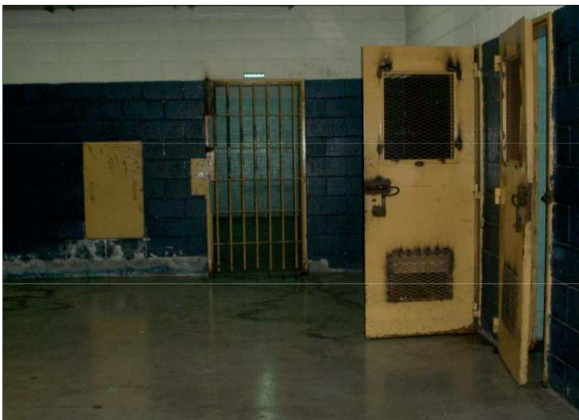
Fuente: PPN, 2011. Celdas de alojamiento del Sector de Ingreso, CPF I.
