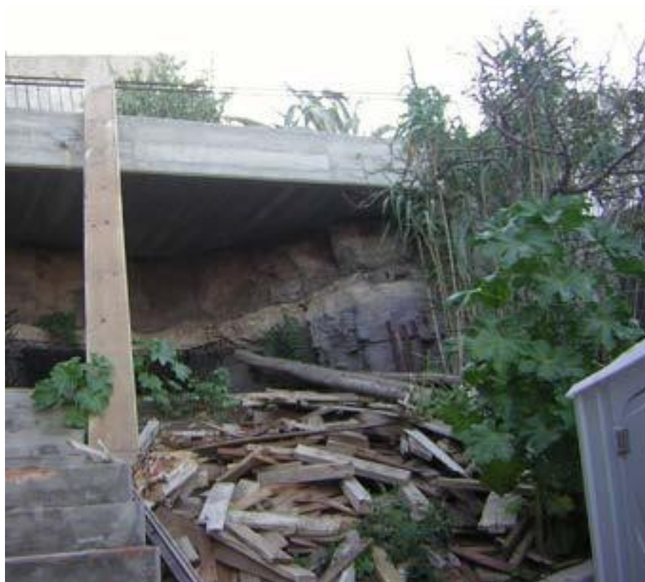
Figura VII.23: Cueva derrumbada donde sólo se observa parte de la pared de arenisca
