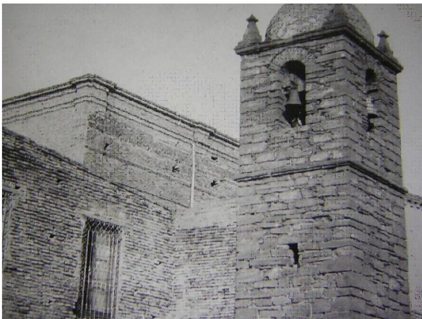
Figura V.5 – Una de las imágenes más antiguas que se conservan del Fuerte de Patagones (año 1881), detalle de su torre (aún en pie). Archivo Fotográfico AGN
