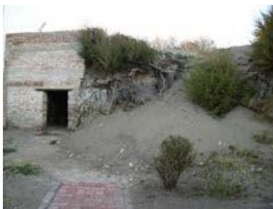
Figura VII.19: vista del frente de la cueva una vez concluida la restauración (Fotos gentileza Dirección Patrimonio Histórico de Patagones)
