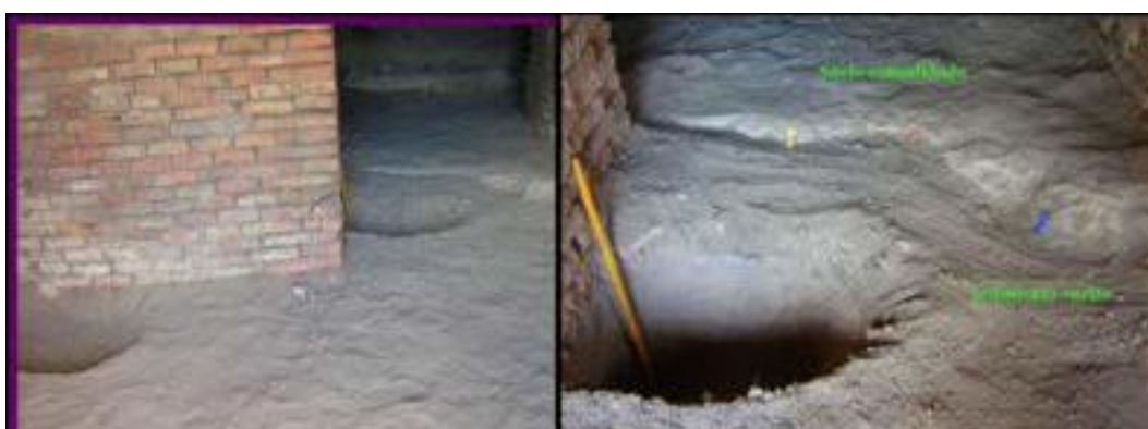
Figura VII.52: sondeos y vistas de las diferencias del sedimentos al interior de las cámaras
