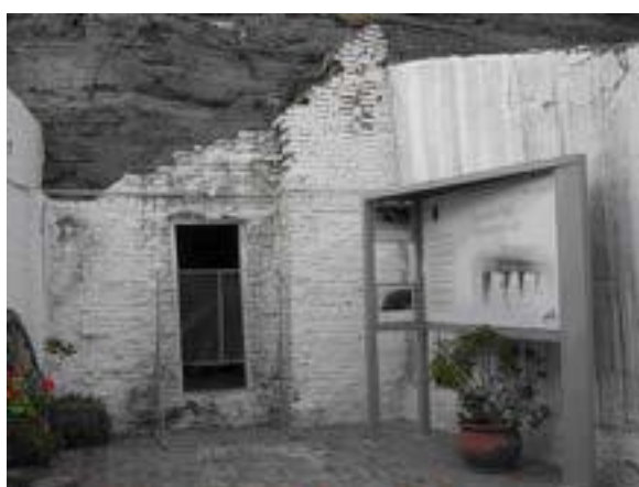
Figura VI.4 - Cueva en el fondo del patio del Rancho Rial (Ex propiedad de Juan José Rial). Ver barranca de arenisca sostenida por ladrillos y puerta de acceso a la cueva reforzada con marco de madera
