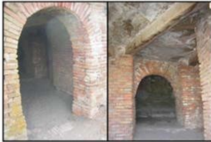
Figura VII.55: Detalles del interior de CM2 donde se observa el sostén con ladrillos cocidos que revisten tanto paredes externas como internas, así como las vigas de fuertes maderas que sostienen el techo
