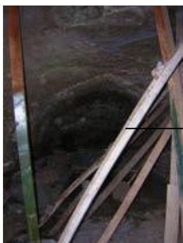
Figura VII.12: Andamios en el interior de la cueva
