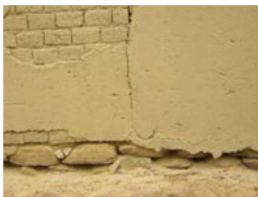
Figura IX.13 - Detalle pared con revoque de barro
