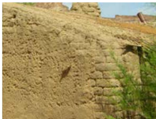
Figura IX.19- vista externa del techo
