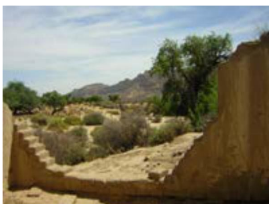
Figura IX.12 -Detalle pared de adobes
