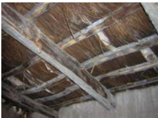
Figura IX.18 - Detalle techo de carrizo
