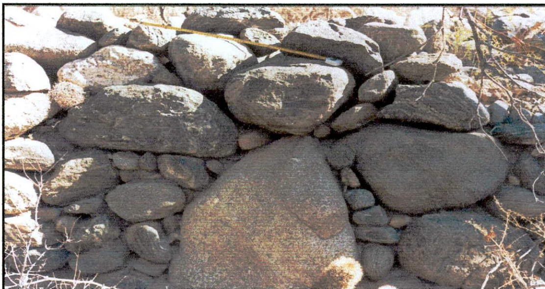
Figura 7.1 – Detalle de la una pared de la Unidad Arquitectónica 4, sector Conoide.
