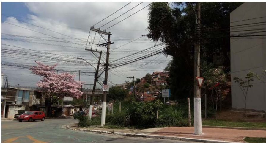
Figura 5. Casas de autoconstrução na parte oeste da Vila Andrade. Fonte: Gabriella D. Dantas De Biaggi, 2018.
