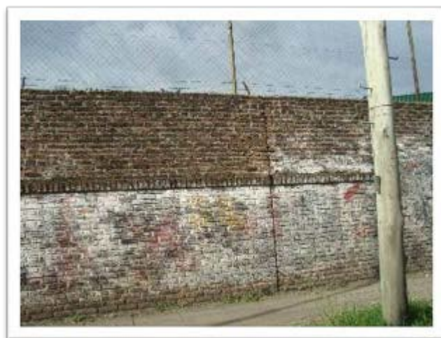
Fotografía 3. Los alrededores de la escuela, el paredón de la fábrica
